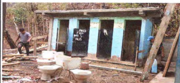
Foto 7: SUSTITUCION DE TECHO Y TAZAS SANITARIOS.
